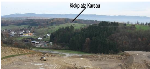
Autobahnverlauf von Baustelle Auffahrt Minseln Richtung alter Kickplatz Karsau
